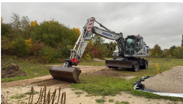
Abb. 3: Baggerarbeiten (10.10.2024, Foto: T. Demuth)
