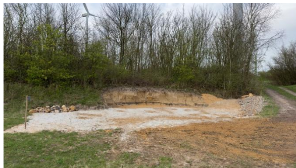
Abb. 13: Fertige Steilwand (27.03.2024, Foto: T. Demuth)
