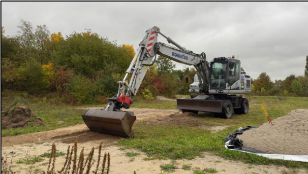
Start der Baggerarbeiten
