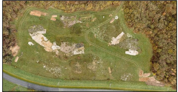
Projektfläche im Überblick mit der neuen Steilwand am linken Bildrand (27.11.22)
