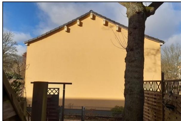
Neue Spatzenquartiere bei der SAGA in Groß Borstel (sh)
