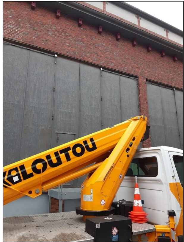
Vom Steiger aus wurden die 10 Kästen montiert
