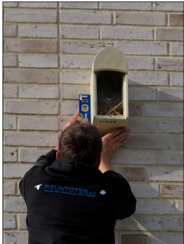
Projektleiter Simon Hinrichs sorgt für gerade Wände (Z. Wilson)
