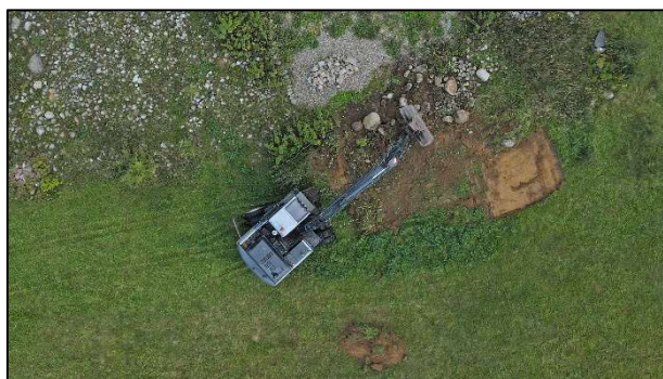
Baggerarbeiten nach unseren Vorgaben, 29.09.20 (td)
